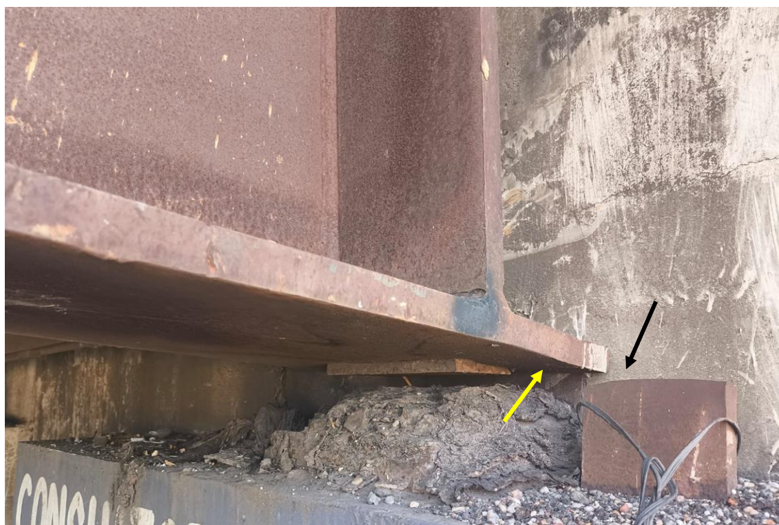
Figura 5 – Ruptura com separação entre os trechos horizontal e vertical de uma das garras indicada pela seta preta (faixa sentido Centro); deformação da mesa inferior da longarina (seta amarela).
