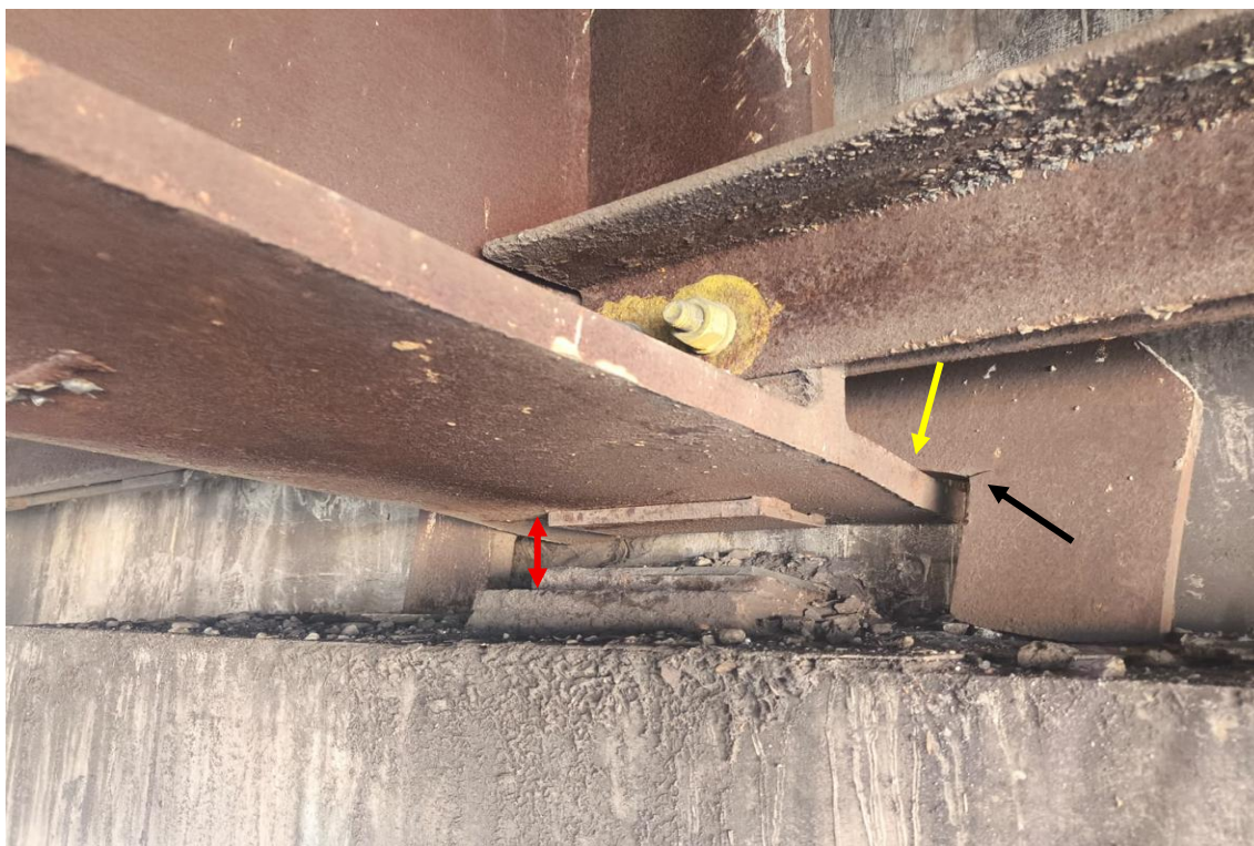
Figura 4 – Abertura de fissura no canto interno, côncavo, de uma das garras que impedem a subida do balanço (seta preta); deformação da mesa inferior da longarina (seta amarela); folga existente no apoio entre o console e a mesa inferior da longarina (seta vermelha).
