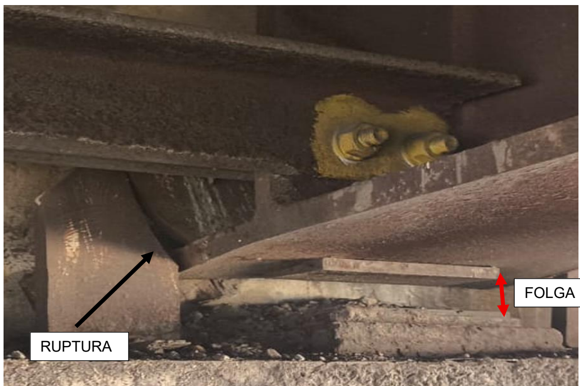
Figura 6 – Propagação da fissura e iminência da ruptura com separação entre os trechos horizontal e vertical de uma das “garras” (seta preta); folga criada no aparelho de apoio que impede a transmissão de compressão (seta vermelha).
