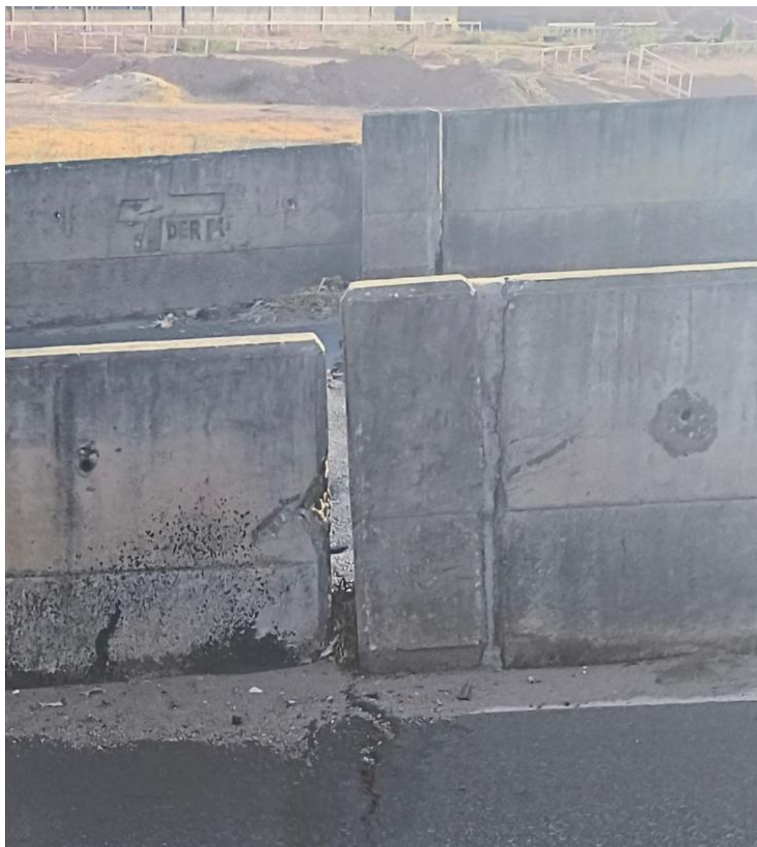
Figura 3 – Diferença entre as juntas da mediana e externa da faixa sentido Centro.
