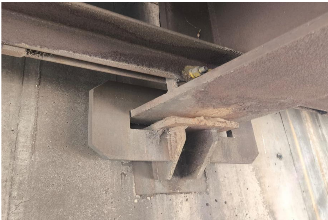
Figura 8 – Vista de um aparelho de apoio do lado Sul, que se apresenta íntegro e funcional, embora com alguma sujeira acumulada por falta de selante de vedação na junta de dilatação correspondente, localizada no tabuleiro
